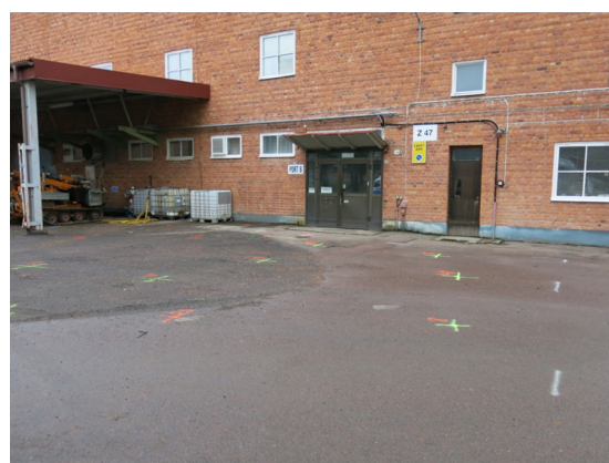
Figur 1: Markeringar på asfalt visar planerade injekteringspunkter för fullskaleprojektet. Foto: Kristin Forsberg SGU
