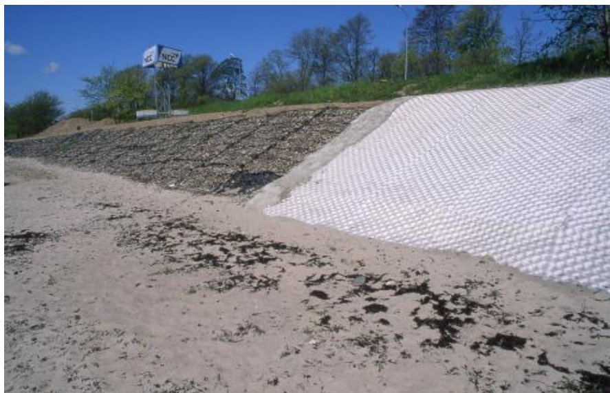
Figur 2: Exempel på åtgärd – försök med erosionsskydd (foto Esko Daniel)
