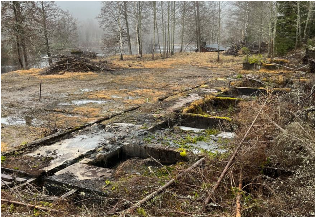
Figur 22. Grunden till det tidigare anrikningsverket, fotograferat 2024-04-11.
