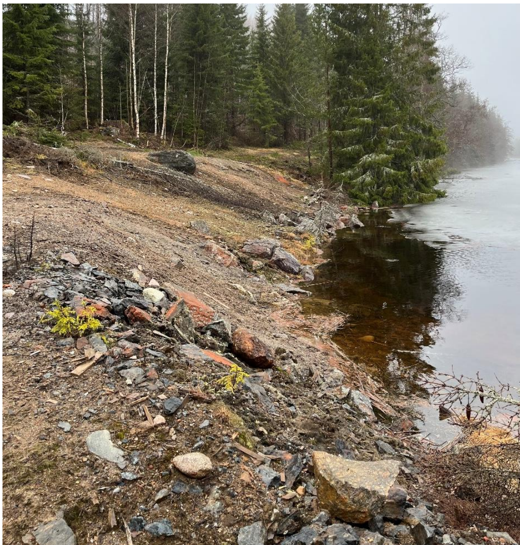
Figur 5. Strandlinjen inom delområde 1 där sökta åtgärder omfattar sanering samt anläggande av strandskoning. Foto taget 2024-04-11.
