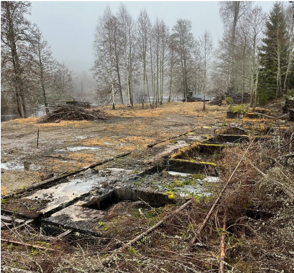
Figur 4. Visar delområde 1 med kvarvarande betongkonstruktion (betongbassänger) från anrikningsverket. I bakgrunden syns taket på smedjan vid vattnet. Foto taget 2024-04-11.
