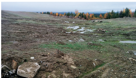
Södra dagbrottet har täckts med morän.
