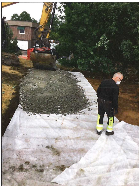
Figur 3. Utläggning av geoduk före återfyllning efter schaktsanering till avsett schaktdjup.
