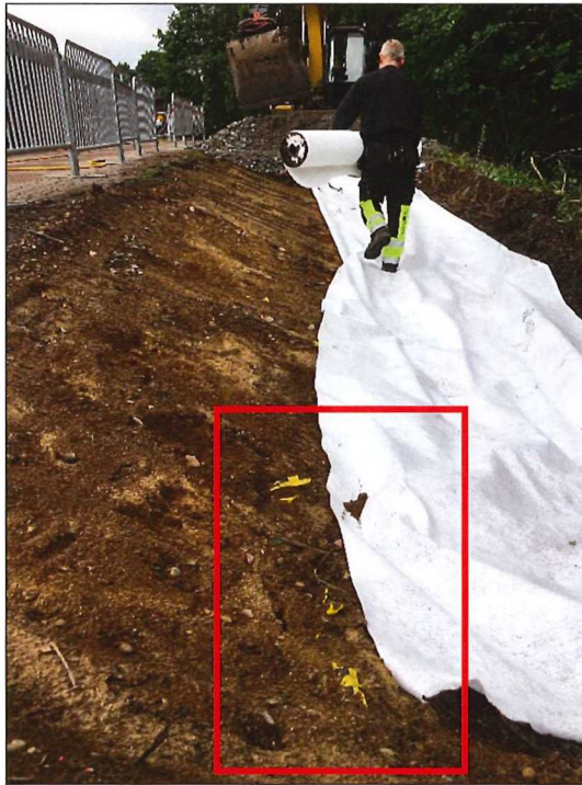
Figur 5. Släntning längs med gc-banan. Påträffad starkströmskabel är markerad med röd rektangel.
