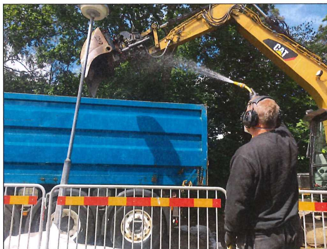
Figur 4. Bevattning av massor under schaktsanering.
