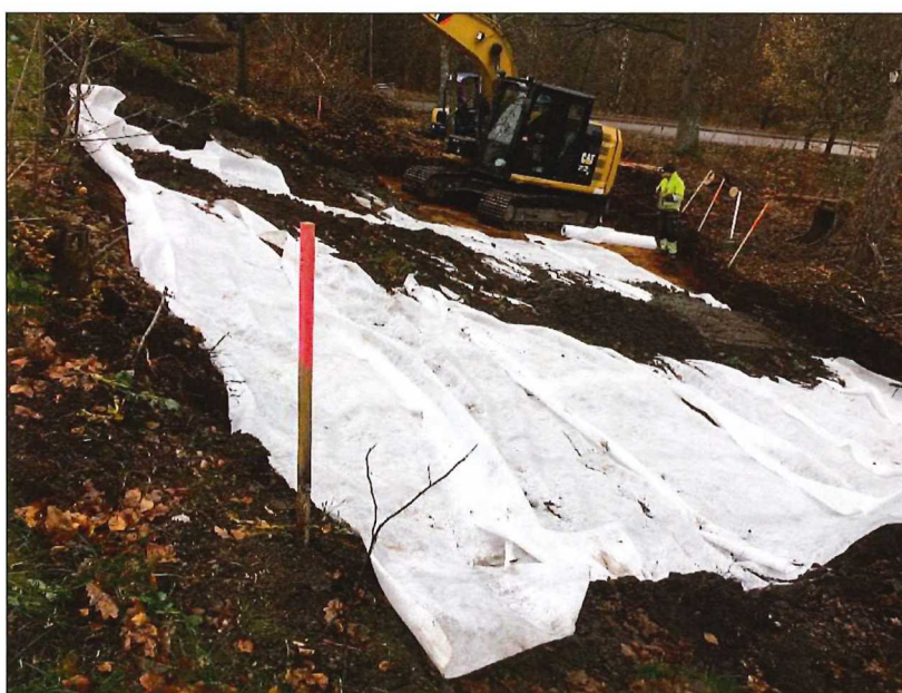
Figur 9. Schaktning i området med f.d. FA-massor ner till 1,5 m.u.my.
