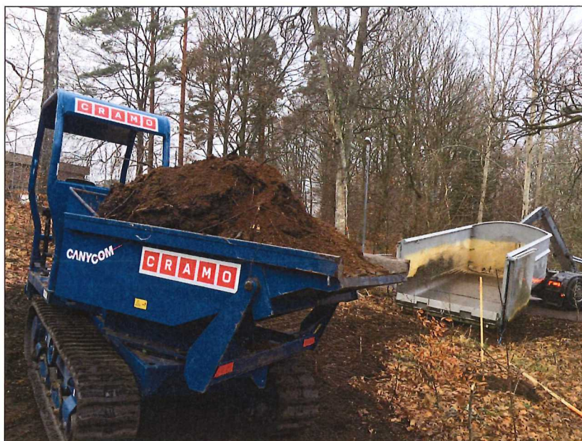
Figur 10. Schaktmassor transporterades m.h.a. minidumper till lastbilsflak.
