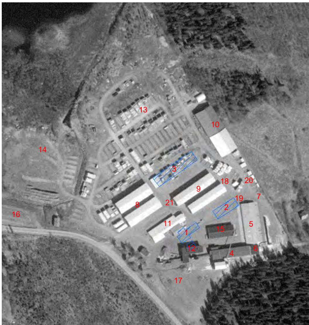
Figur 5. Flygbild från 1985 med byggnader och processer inom verksamhetsområdet. Byggnader markerat med blå skraffering var rivna 1985. ©Lantmäteriet
