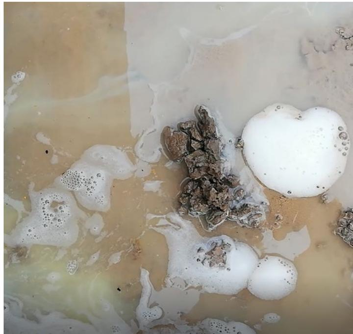
Figur 5 Foto till vänster visar uppträngning av material i marken på flera meters avstånd från injekteringspunkten. Fotot till höger visar i närbild uppträngning av koncentrerade mängder behandlingsmedel som bubblar upp.
