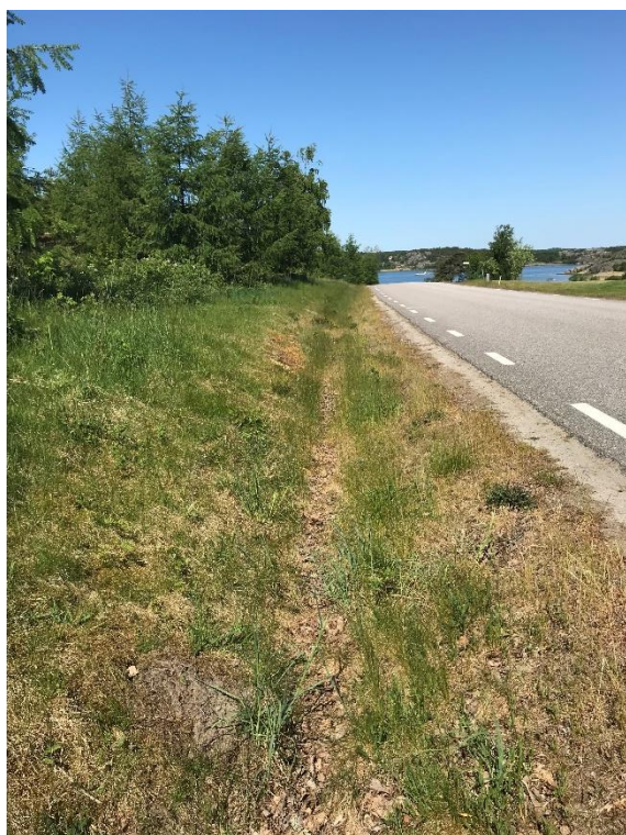
Figur 19: Det provtagna diket från Kårehogen 1:3 mot Malö strömmar. Foto taget vid platsbesök den 23 maj 2018 då det var mycket torrt.
