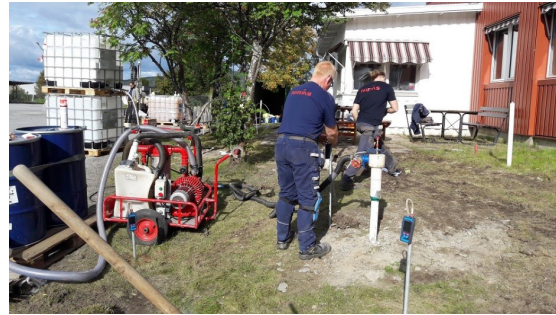
Markventilationsförsök vid tvätteriet hösten 2017. Foto: NIRAS.
