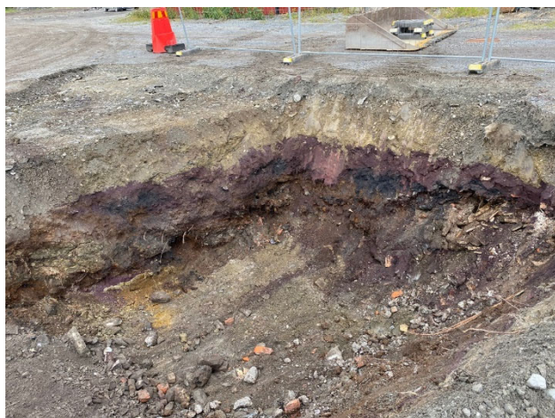
Kisaska i en schaktgrop. Kisaska är en rödbrun rest från sulfittfabriken som påträffas i utfyllnader i stora delar av fabriksområdet och som ofta klassas som farligt avfall.
