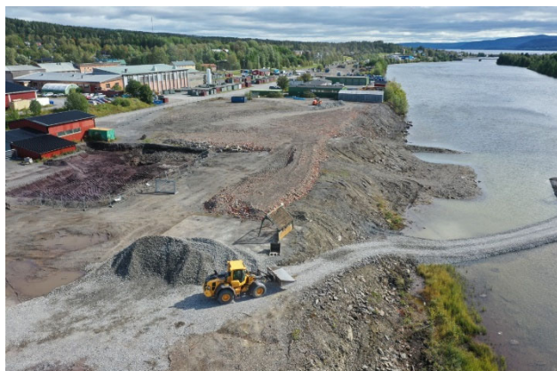
Arbete har pågått både på land och i Järpströmmen under 2021-2022.. Farligt avfall har transporterats till Umeå med tåg.
