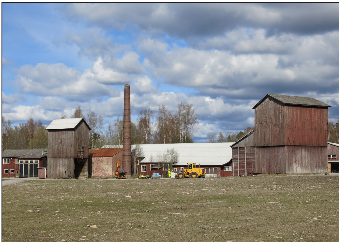
Figur 1. Injektering av kemiskt oxidationsmedel vid det f.d. sågverket i Hjortsberga.
