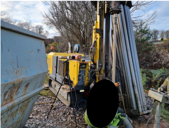
Figur 2. Borrhäng som utför hammarborrning. Person har censurerats i bilden
