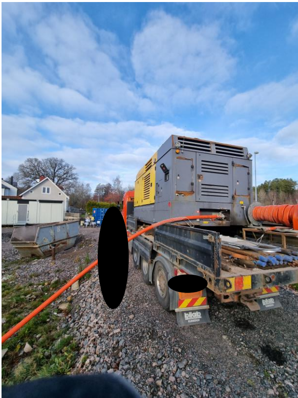
Figur 1. Lastbil med kompressor som kopplas till borriggen. Person och registreringsnummer har censurerats i bilden
