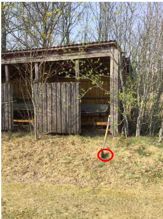
Figur 5. ND, B, 7, 1. Östra hörnet på tvättrumets södra sida
