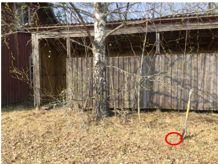
Figur 7. ND, B, 7, 3. Mitten av tvättrumets södra sida.
