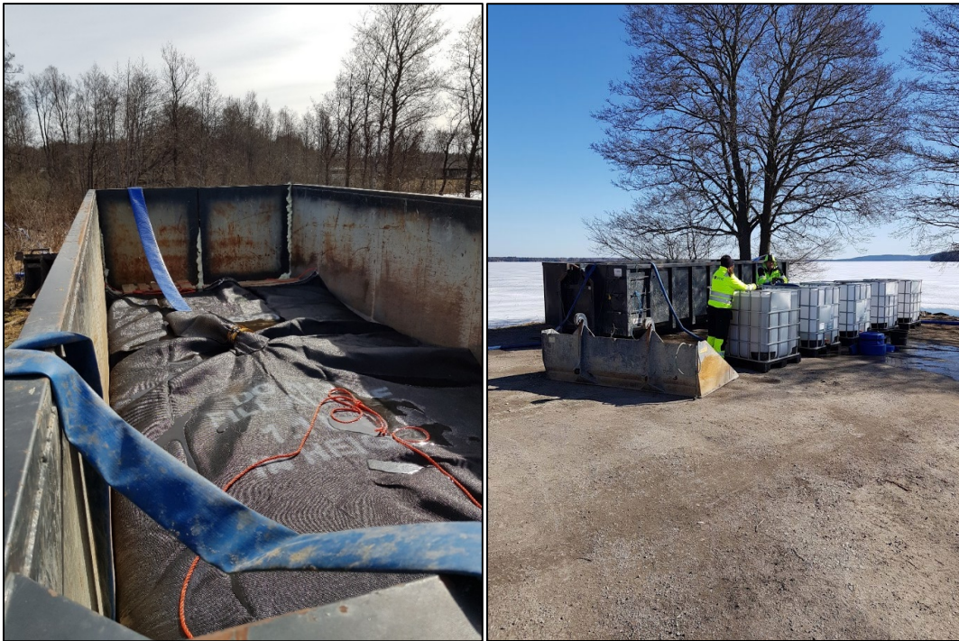
Figur 20. Fyllning av geotub och uppsamling av rejektivatten under pågående pilotförsök.
