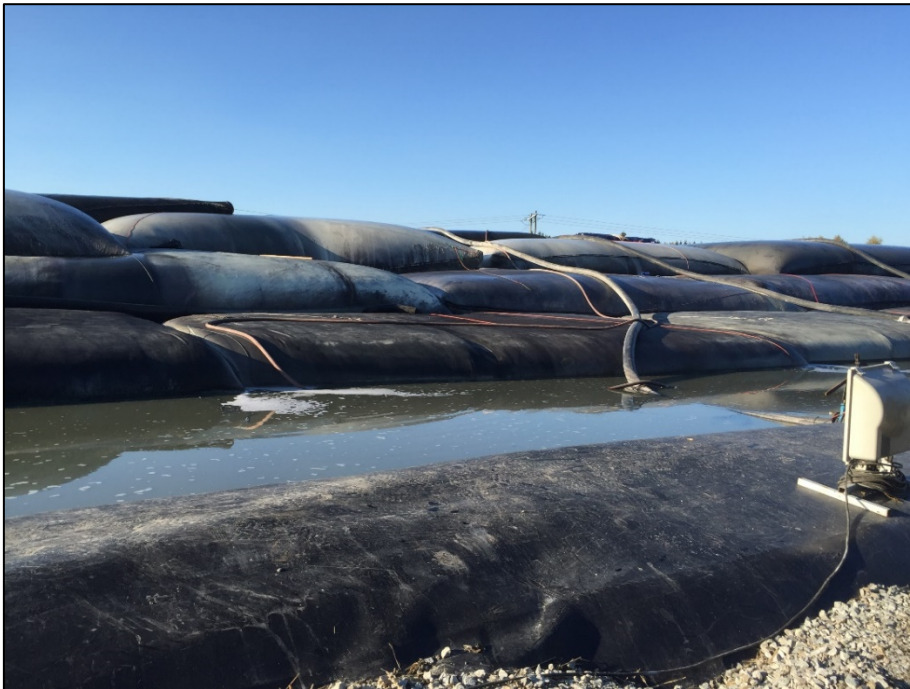
Figur 18. Exempel på upplag av geotuber på tät invallad avvattningsyta.
