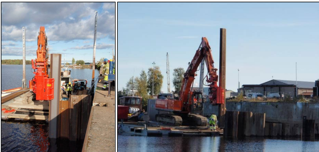
Figur 13. Exempel på installation av stålpont som skyddsbarriär vid ett liknande saneringsprojekt i Stenborgskanalen, Gävle kommun, år 2009.
