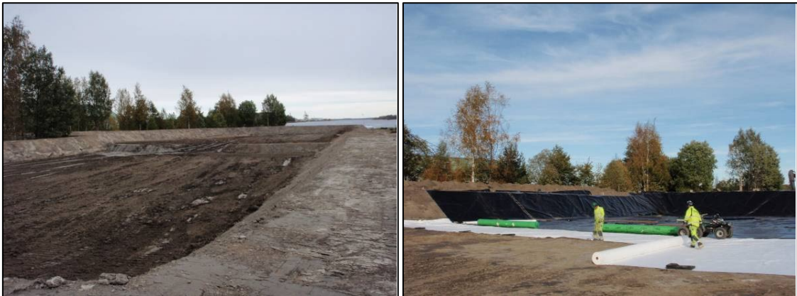
Figur 12. Till vänster ett exempel på avjämnd och invallad avvattningsyta. Till höger pågående installation av HDPE-duk med underliggande geotextil.
