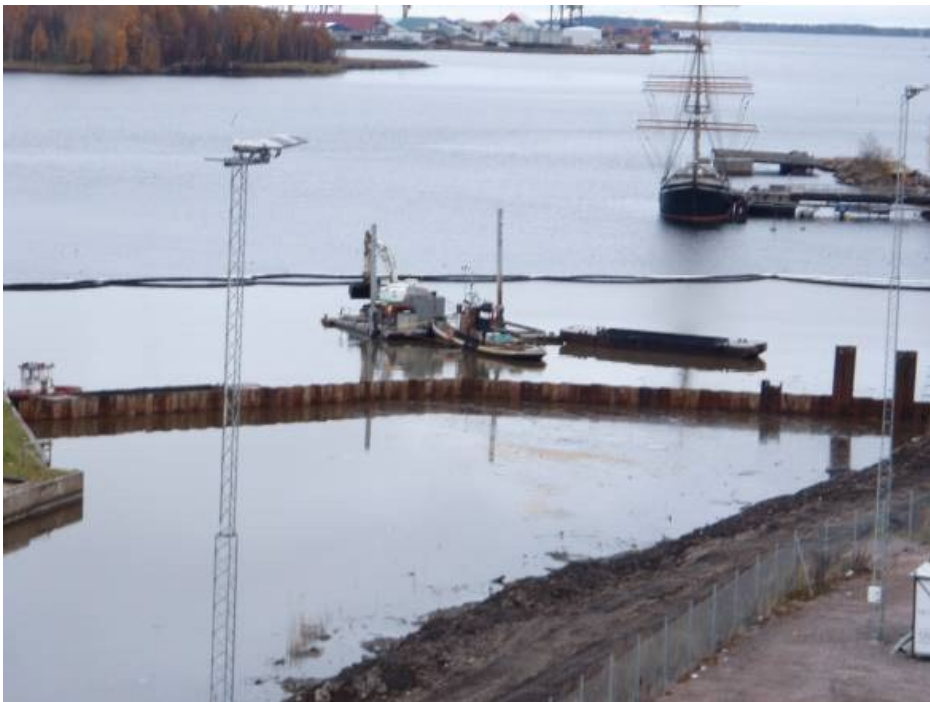
Figur 14. Pågående grävuddring i det yttre åtgärdsområdet innanför siltskärm och oljeläns. Stålsporten avgränsar det inre och mer föroreningsbelastade området vid Stenborgskanalen i Gävle.
