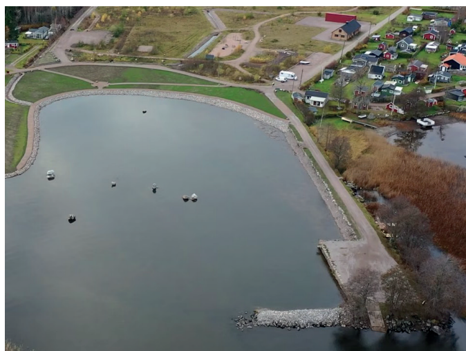
Invallningen efter slutförd sanering. Oktober 2022.
