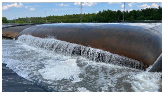
Muddermassor i geotuber som finns på Åsbro nya impregneringsplats kommer att tas omhand hösten 2024
