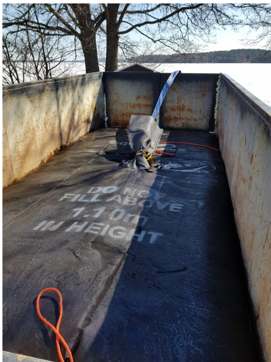
Geotub som avvattnar förorenade sediment. Foto: Structor
