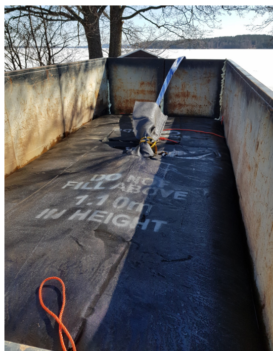
Geotub som avvattnar förorenade sediment". Foto: Structor
