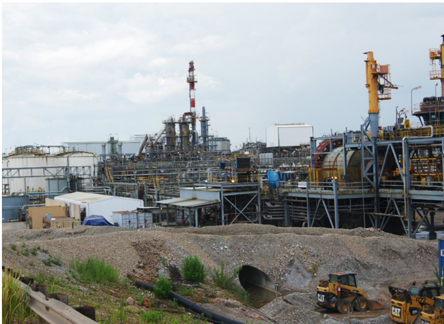
Vy över delar av anrikningsverket i Tenke, Haut-Katanga, DR Kongo. Här anrikas en stor del av det kobolt som utvinns i DR Kongo. Anrikningsverket anrikar koppar och kobolt i flera processteg. Foto: Mattias Fackel
