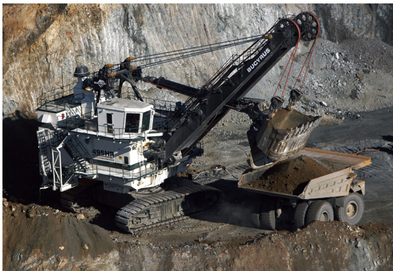
Lastning av sprängda massor. Foto: Thompson Creek, Kanada.
